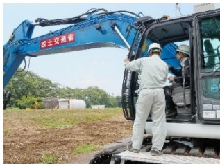
建設機械施工実習
