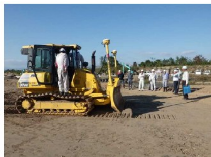
ICT-MC建機(ブルドーザ)の実践
