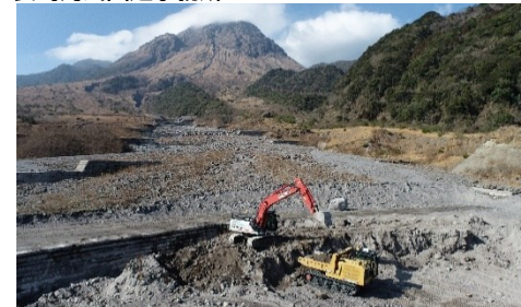
除石、土砂運搬（自動走行）
