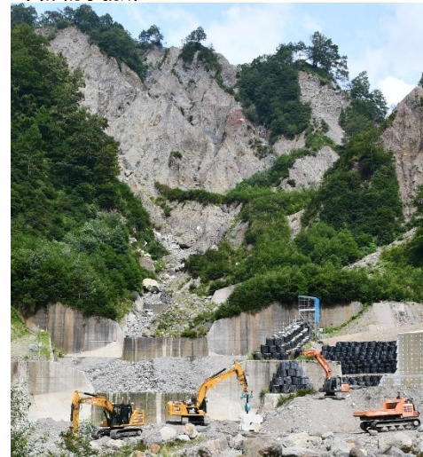
掘削、土砂運搬、ブロック据付
