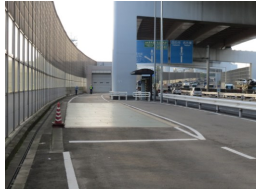
車両重量計設備の事例
