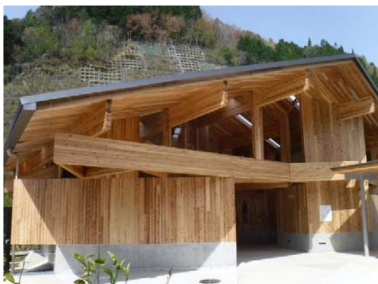
道の駅 トイレ新築工事 国道373号 道の駅あわくらんど (岡山県西栗倉村)
