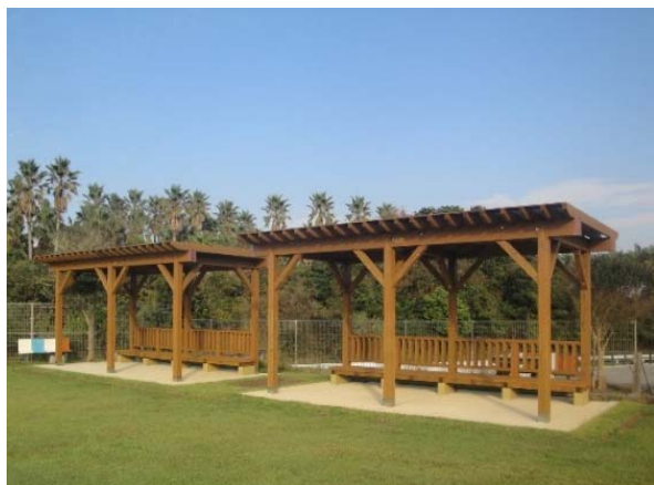
水尻公園（鹿児島県枕崎市）：休憩施設
