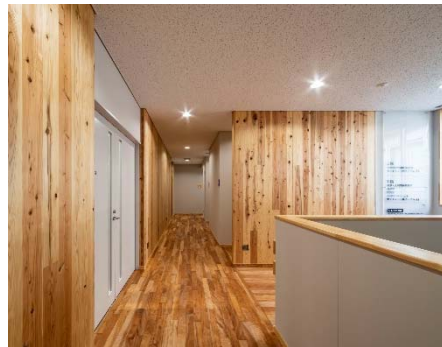
嶺北森林管理署(高知県長岡郡本山町)：庁舎（CLT パネル工法）
