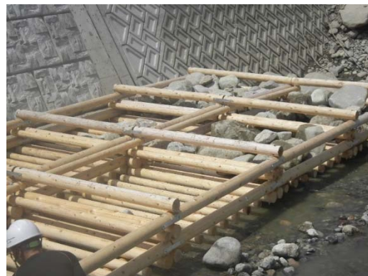
千代川水系八東川（鳥取県若桜町） 『木工沈床』
