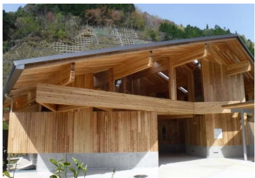
(道路) 道の駅トイレ新築工事 (岡山県西栗倉村) : 道の駅あわくらんど
