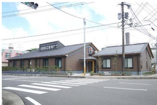
西都児湯森林管理署(宮崎県西都市)：庁舎（軸組構法・CLT パネル工法）
