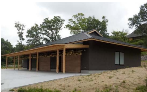
(公園) 国営明石海峡公園 (兵庫県神戸市) : 倉庫
