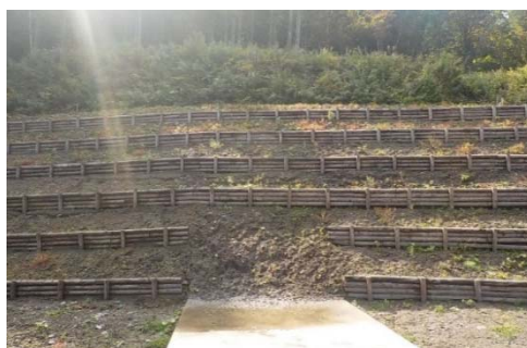
(河川) 気門別川水系紋別川 (北海道伊達市) : 『法面工 (木柵)』
