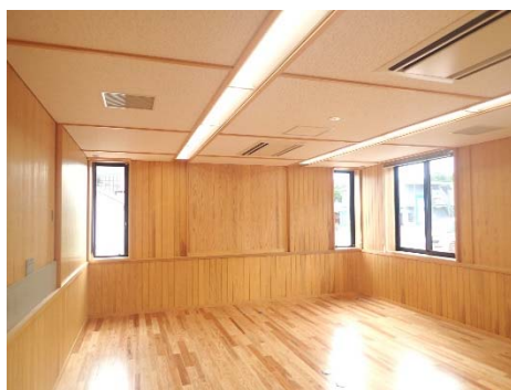
西都児湯森林管理署(宮崎県西都市)：庁舎（軸組構法・CLT パネル工法）
