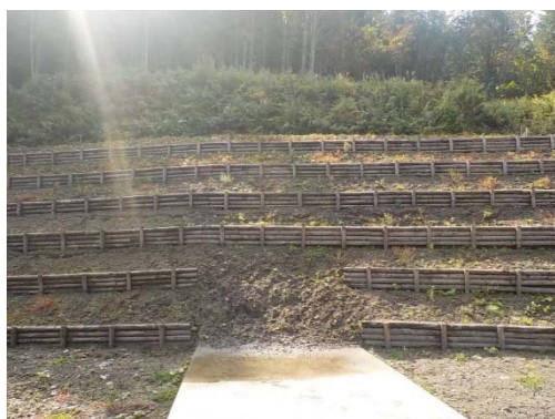
気門別川水系紋別川（北海道伊達市） 『法面工（木柵）』
