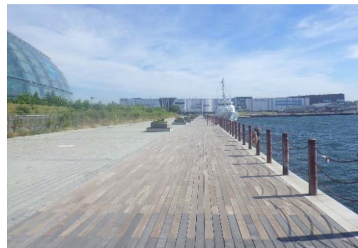
(港湾) 小名浜港 (福島県いわき市) : ボードウォーク
