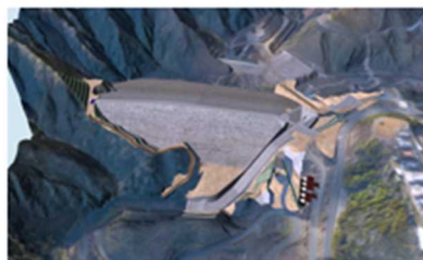
堤体盛立完了
