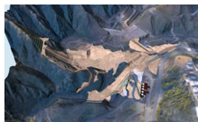
基礎掘削完了・仮設備配置
