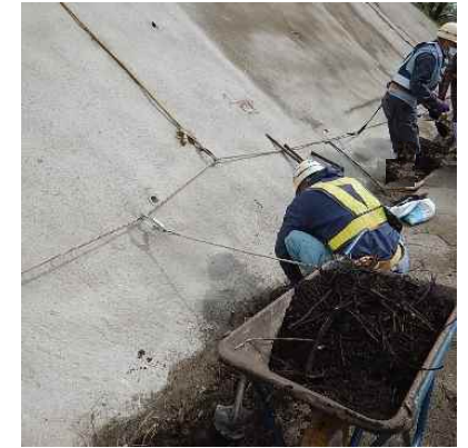
作業時なるべく離隔を確保
