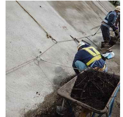
作業時なるべく離隔を確保
