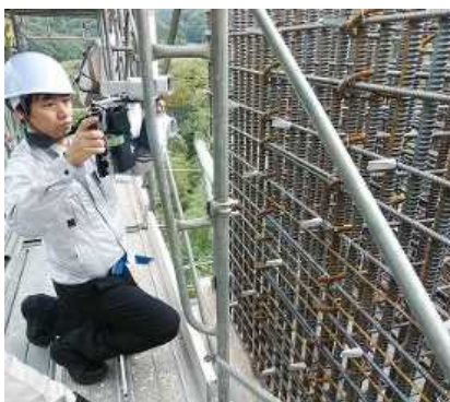
システムによる配筋検査
