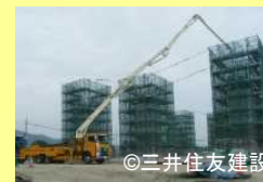
中詰めコン打設
