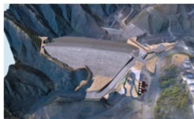
堤体盛立完了
