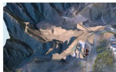
基礎掘削完了・仮設備配置
