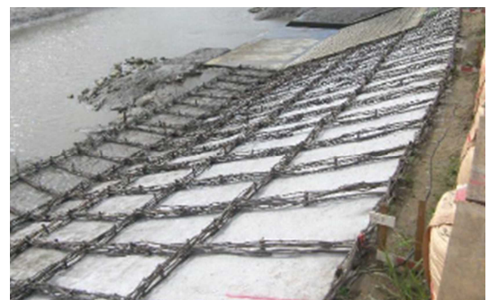
筑後川水系切通川（佐賀県神埼市） 『護岸工』
