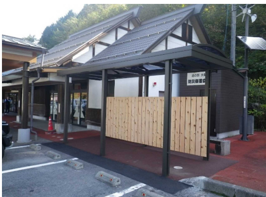
道の駅 トイレ改修工事 国道19号 道の駅大桑 (長野県木曽郡大桑村)
