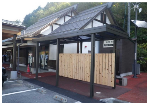
(道路) 道の駅トイレ改修工事 (長野県木曾 郡大桑村) : 国道19号 道の駅大桑
