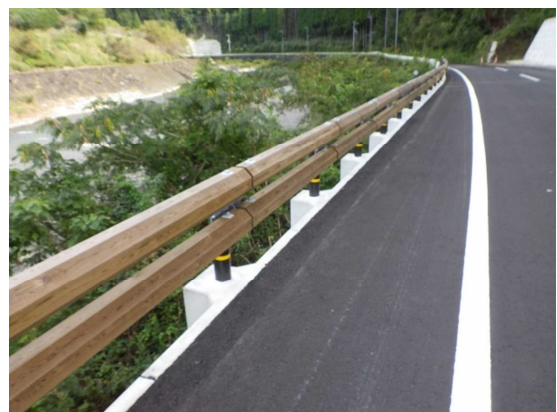
木製ガードレール 国道480号 (和歌山県有田川町)
