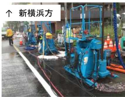
写真-6 6/13 注入作業状況
