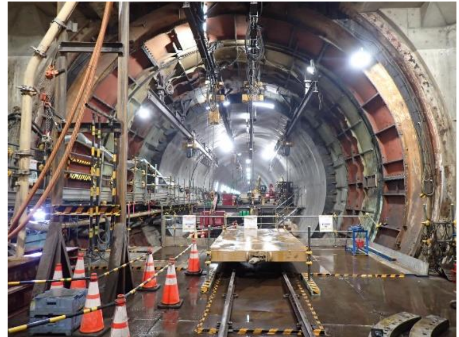
シールドマシン解体状況
