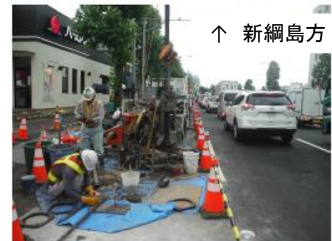
写真-6 7/1 注入作業状況
