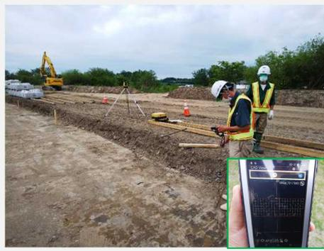
ブロック布設図面データが入力されており、位置出ししたい箇所にターゲットを誘導する。
