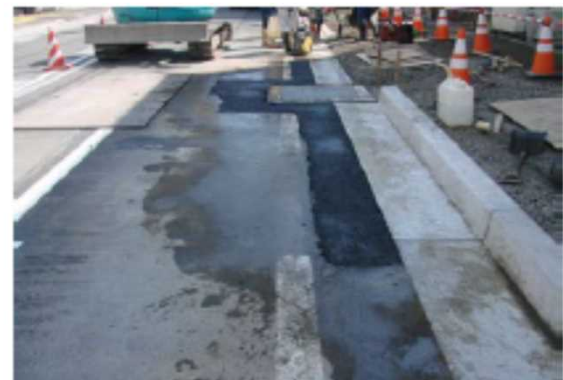
L型側溝埋戻し、復旧舗装
