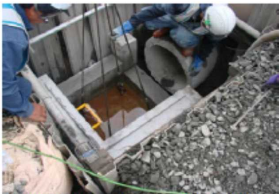
床堀+基礎碎石設置後、樹下部据付
