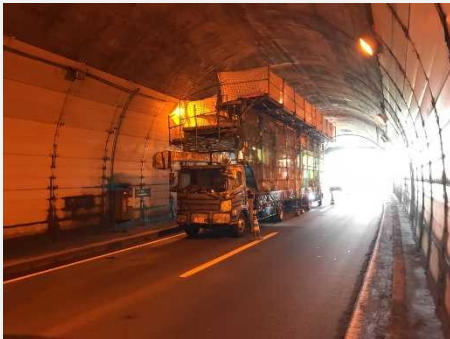
移動式足場使用全景
