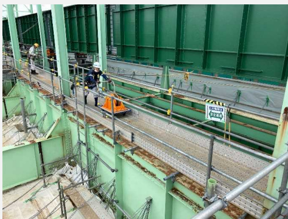
1個約200kgの運搬状況
