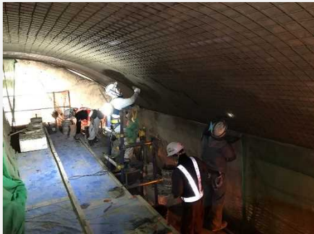
移動式足場作業床での作業状況
