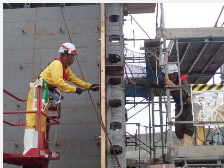
セパ材取付状況(拡大)
