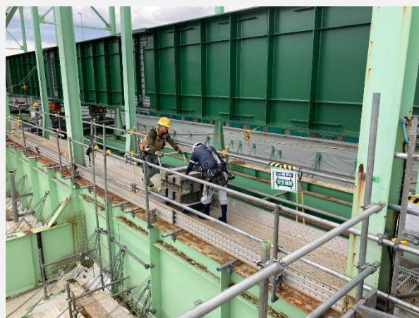
一度に大量の資機材を運搬する状況
