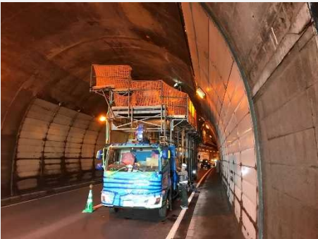
移動式足場使用全景
