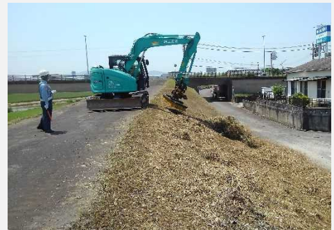
チルトローテータ仕様バックホウ及び機械式スーパーブラシ使用状況
