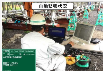
自動緊張状況 (自動緊張管理システム使用状況)
