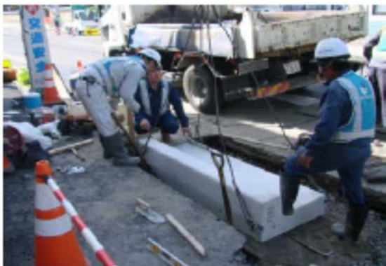
樹埋戻し後、L型側溝部基面整正+据付
