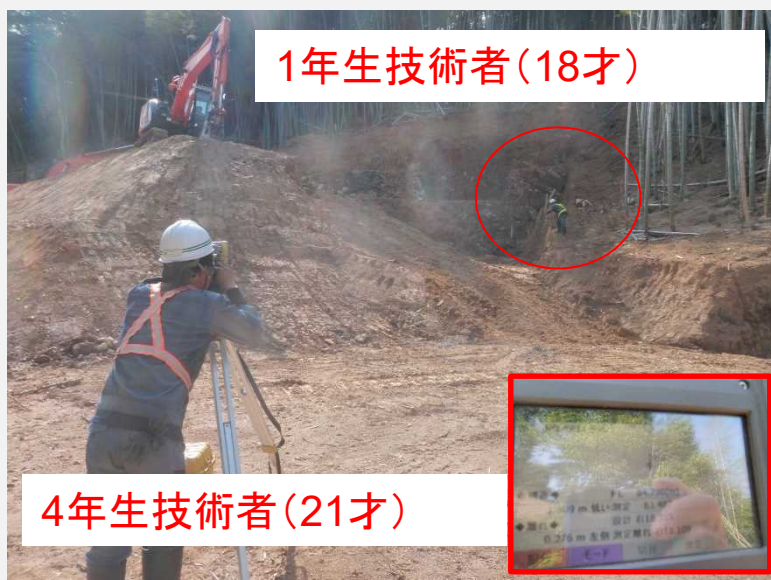
A1橋台掘削の測量作業中
