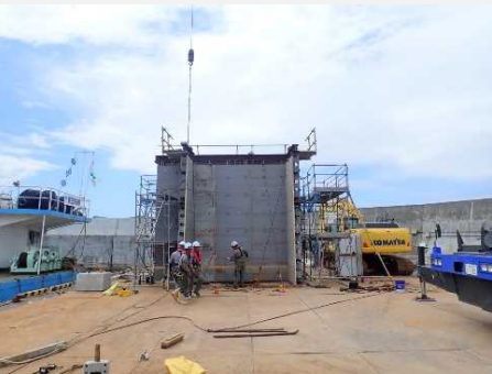
鋼製枠建込状況 躯体寸法H=4.5m
