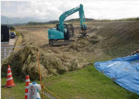
チルトローテータ仕様バックホウ及び機械式スーパーブラシ使用状況
