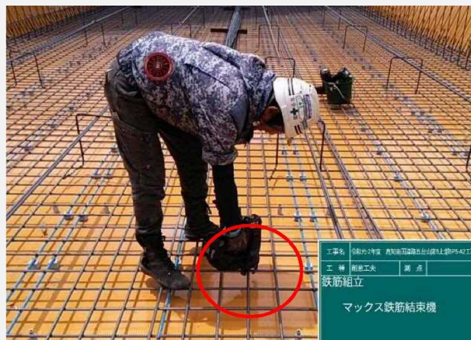
【鉄筋結束機使用状況】
