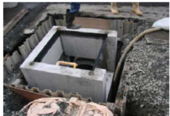
樹上部据付後、接続部取付
