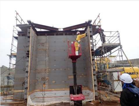
セパ材取付状況(高所作業車)
