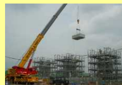
クレーンで設置
