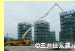
中詰めコン打設
