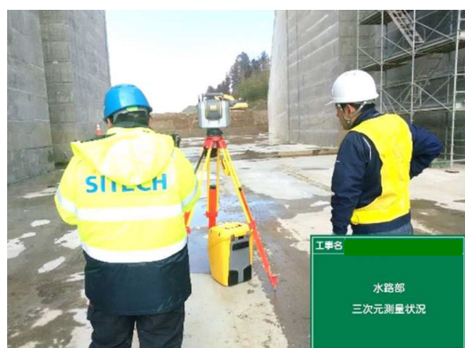
3D計測状況（壁側面）
