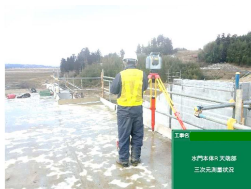
3D計測状況（壁上面）
