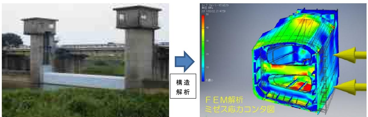
従来の手計算による強度計算の確認および強度計算の確認および強度不足箇所の発見、さらには成果品の精度向上の効果がある。
