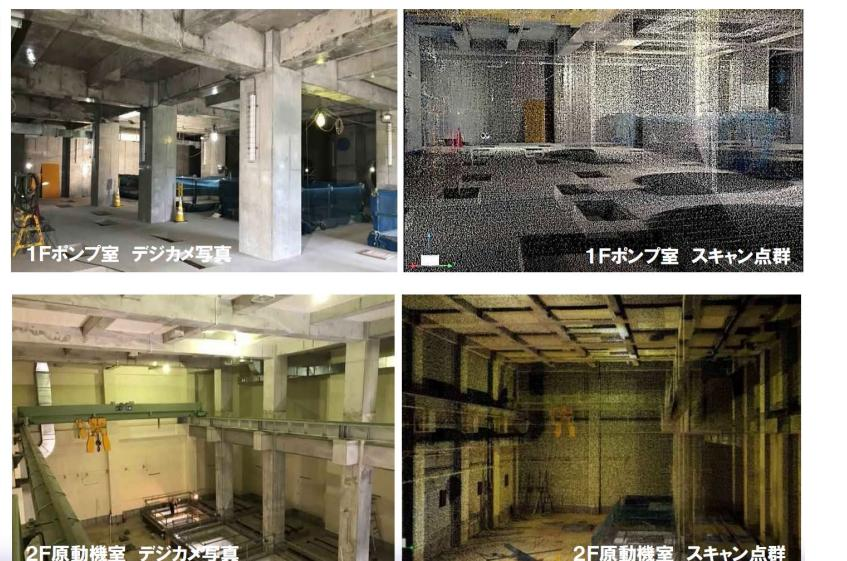
また、既存設備が錯綜する狭隘な空間では、運搬時に既存設備との接触による損傷・挟まれ等の事故が生じる恐れがあるため、3次元モデルを用いて高精度で立体的に可視化することで安全管理の効率化、高度化が期待できる。
