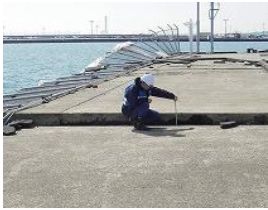
津波警報解除後の現地調査(陸上)
