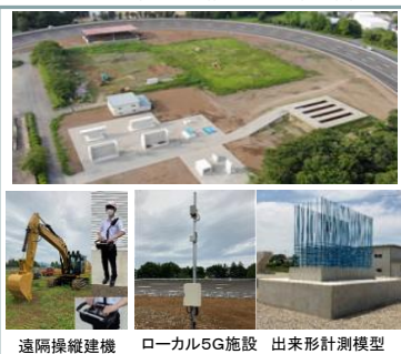
遠隔操縦建機 ローカル5G施設 出来形計測模型
