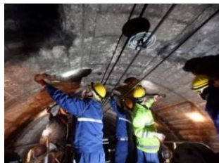
トンネル内の目視点検・打音調査の様子
