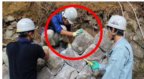
熟練技能者による身体負荷の大きい施工
