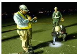
<ひび割れ計測>
