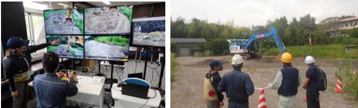
無人化施工研修で、無人化施工機械の基本操作を習得
