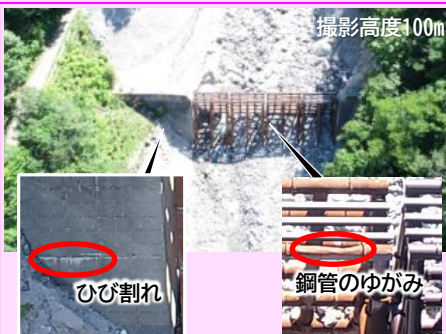
UAVによる砂防施設点検
