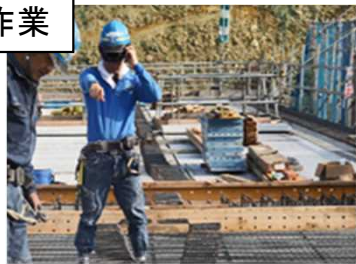
配筋作業者のMRデバイス装着
