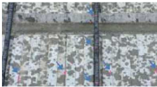
配筋位置のマーキング 複数人でメジャー等により配筋位置を計測の上マーキング
