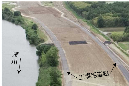
工事完成時の写真 (R4.5撮影)
