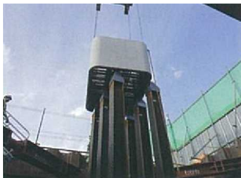
橋梁下部工 橋脚部の埋設型枠
