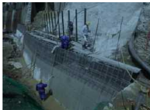
擁壁工 外壁の埋設型枠
