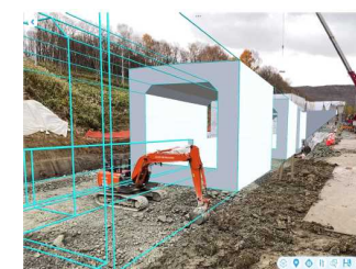
掘削作業時にARと比較
