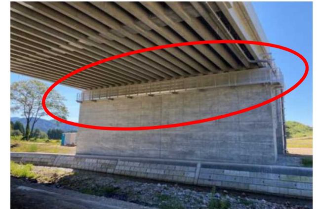
工種名：橋梁検査路架設工
