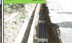
光ケーブル整備
