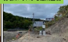
現場カメラによる遠隔監視
