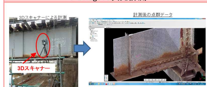
i-Bridge: 3次元計測
