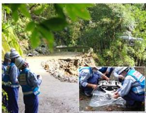
TEC-FORCE等の被災状況の確認は、実際の現場で、赤白ポール等を使って計測していたが、UAVやLiDAR等様々な技術により、短時間で広範囲の調査が可能に！
