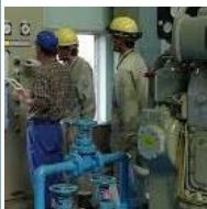
現地で施設の操作
