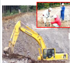
丁張りを目印に施工
