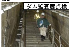
ダム監査廊点検
