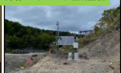
現場カメラによる遠隔監視
