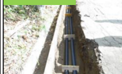
光ケーブル整備
