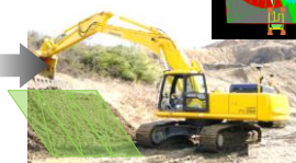
3次元設計データに沿って施工
