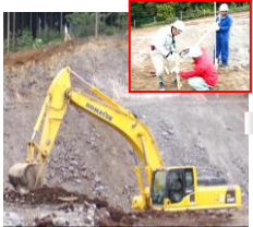
下張りを目印に施工
