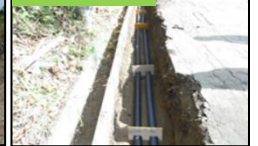
光ケーブル整備
