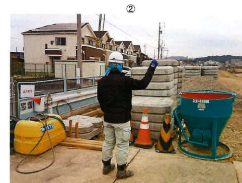
クレーンオペレーターに合図 ④
