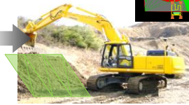
3次元設計データに沿って施工
