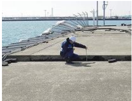
津波警報解除後の現地調査(陸上)
