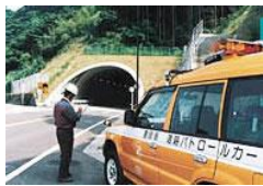
現地状況を目視確認
