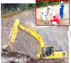
下張りを目印に施工
