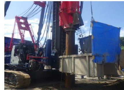
鋼管・既製コンクリート杭打工(中掘工)
