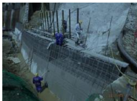
擁壁工 外壁の埋設型枠
