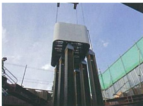
橋梁下部工 橋脚部の埋設型枠
