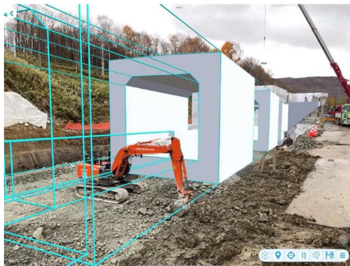
図 5-5 省力化・省人化－施工管理での活用
