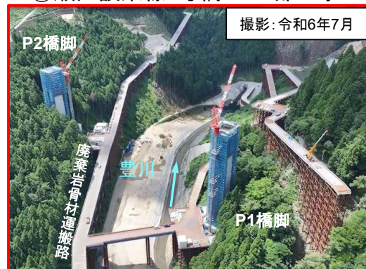
②瀬戸設楽線5号橋PC上部工事
