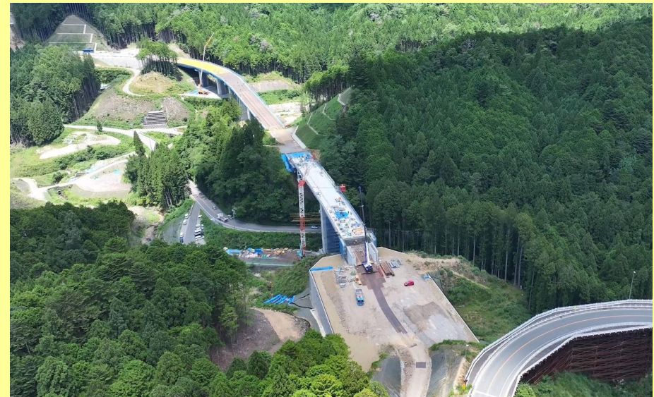
国道257号1号橋～2号橋(R5.3)
