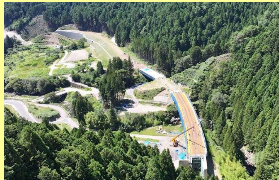
瀬戸設楽線1号橋、2号橋、土工3工区(R6.7)
