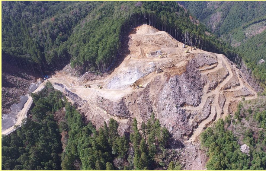
左岸掘削 (R5.3)
