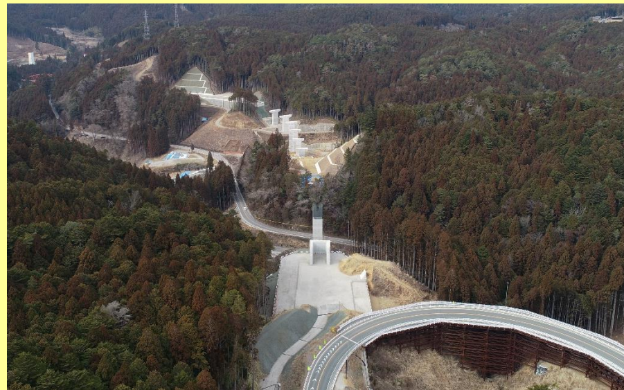
国道257号1号橋～2号橋(R5.3)
