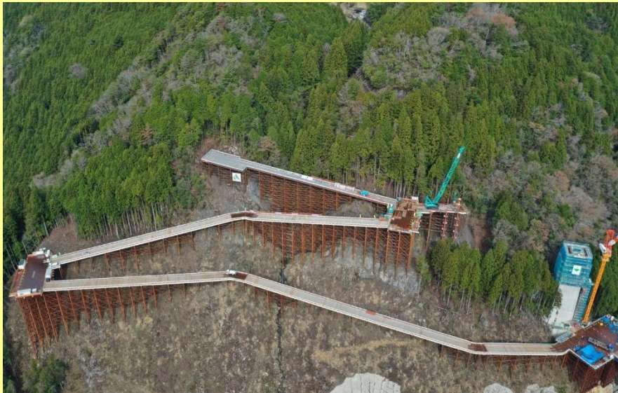
右岸工事用道路 (R5.3)
