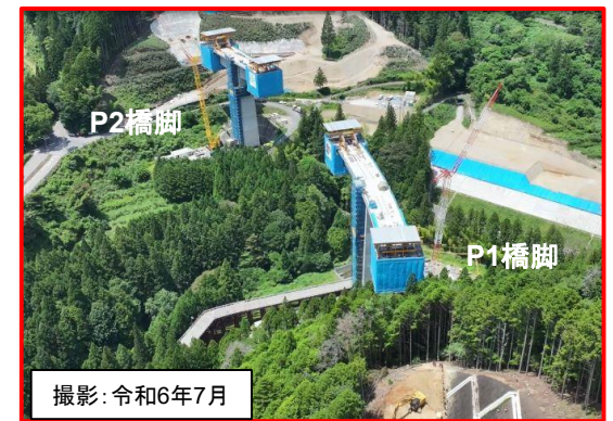
④国道257号1号橋PC上部工事
