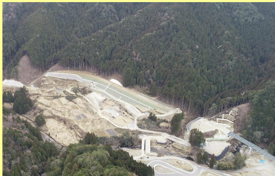
瀬戸設楽線土工3工区(R5.3)
