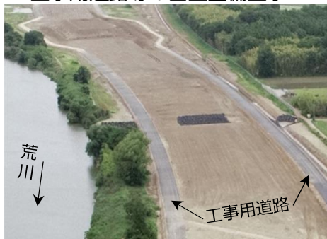
工事完成時の写真（R4.5撮影）
