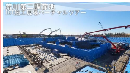
現場施工風景
