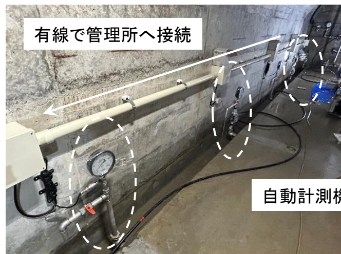
堤体計測(基礎排水孔)自動計測
