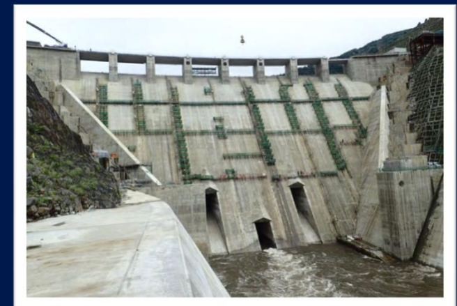
本体施工中の立野ダム
