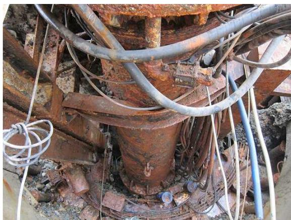
写真 3.3.11 スクリューコンベヤ下部の鋼材の変形
