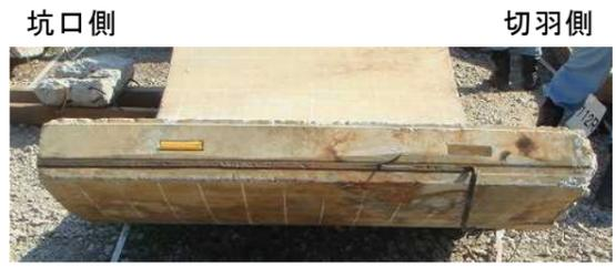
③リング継手 (坑口側：埋込みインサート)
