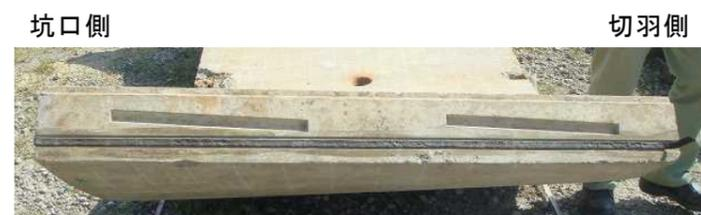
③リング継手(坑口側：埋込みインサート)
