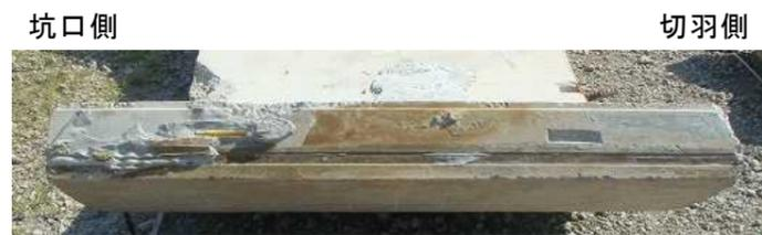
③リング継手(坑口側：埋込みインサート)
