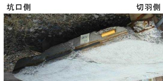
③リング継手(坑口側：埋込みインサート)
