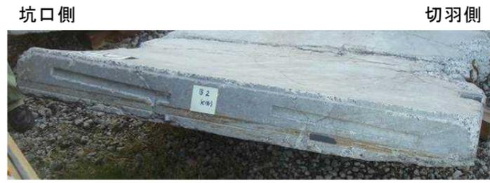
③リング継手(坑口側：埋込みインサート)
