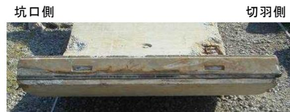
③リング継手 (坑口側：埋込みインサート)
