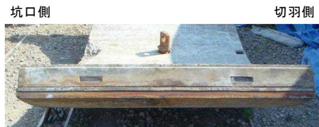
③リング継手(坑口側：埋込みインサート)
