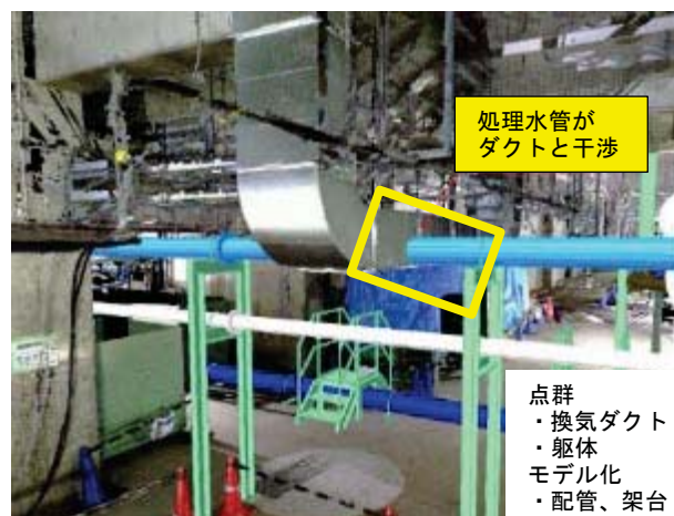
ダクトと配管の干渉チェック（施工段階）
