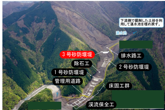
写真-2-8-1 赤谷 3 号砂防堰堤工事
