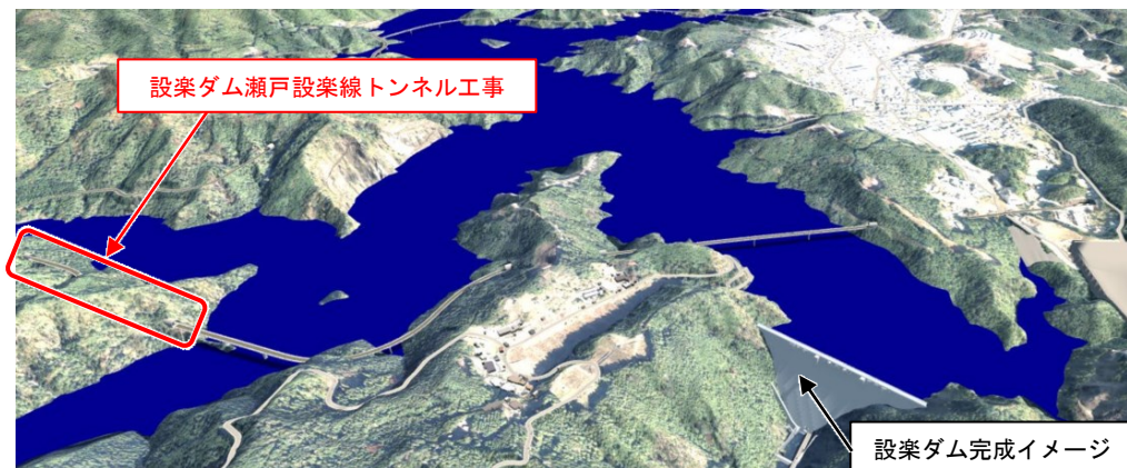
図-2-19-1 設楽ダム瀬戸設楽線トンネル工事
