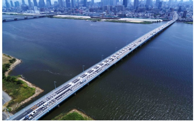
写真-2-1-1 淀川大橋
