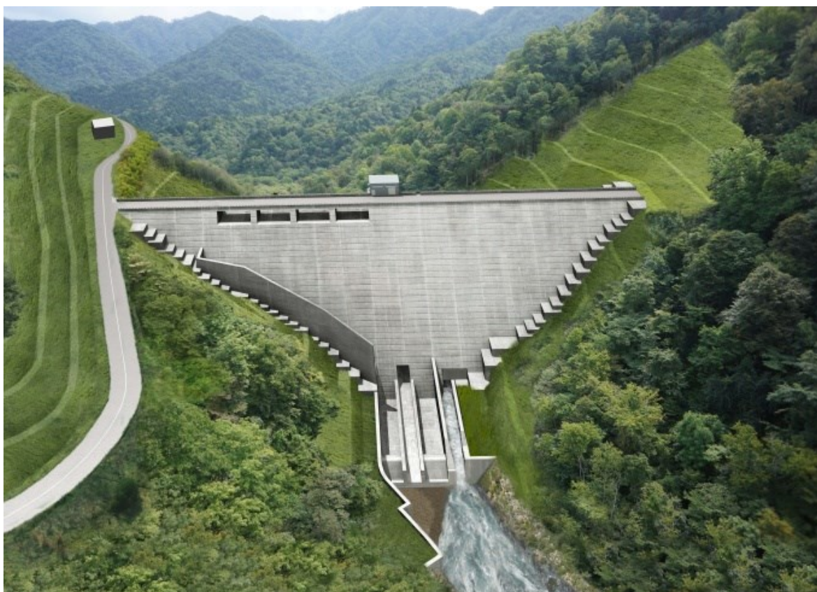
図 参 27-1 三笠ぽんべつダム堤体建設第 1 期工事
