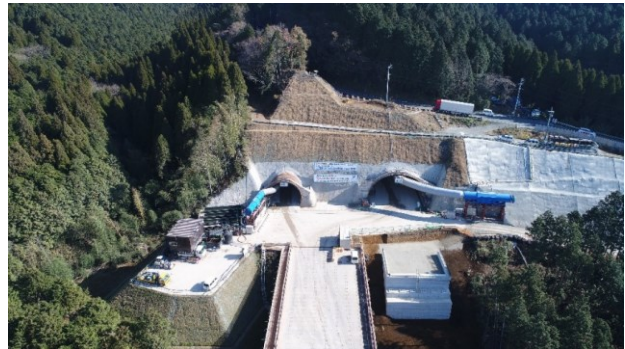
写真-2-2-1 二重峠トンネル
