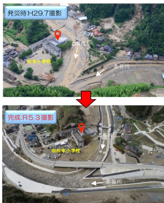
写真-2-16-1 赤谷川災害改良復旧附帯 県道真竹橋架替外工事
