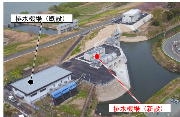
写真-2-15-1 枝光排水機場
