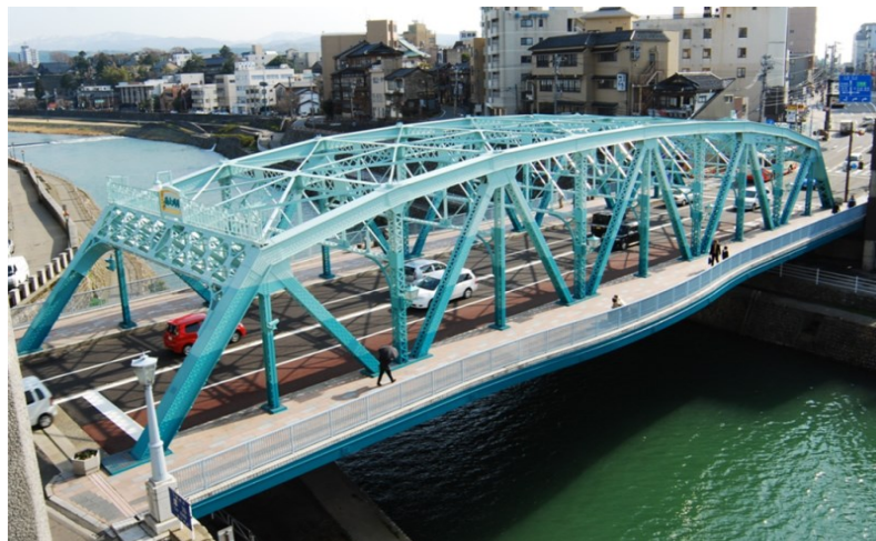
図 参 4-1 国道 157 号犀川大橋
