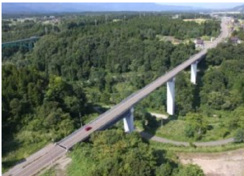
図 参 22-1 妙高大橋上部撤去工事
