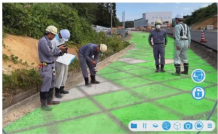
ARを活用した土工の出来形確認
