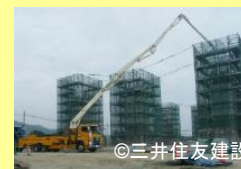
中詰めコン打設
