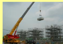
クレーンで設置
