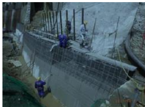
擁壁工 外壁の埋設型枠
