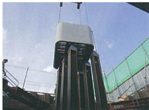
橋梁下部工 橋脚部の埋設型枠
