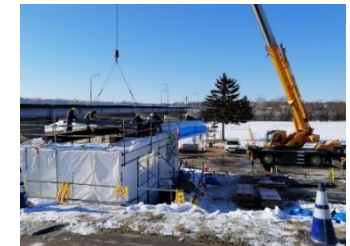
雪寒仮囲い工
