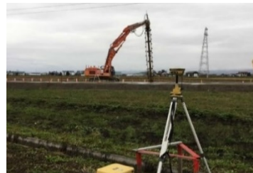
中層混合処理工（ICT）
