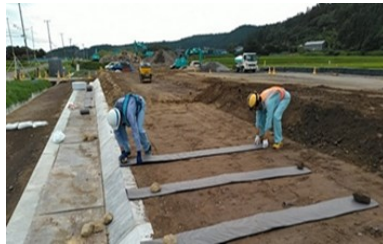
排水材設置工（水平排水層）
