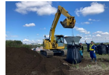
大型土のう工
