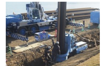
油圧圧入引抜工
