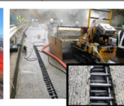
<ウォータージェットはつり処理工法>
