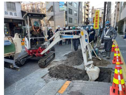
GX建機の実現場での活用事例
