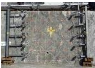
擁壁前面の状況
