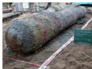
撤去杭の杭長確認
