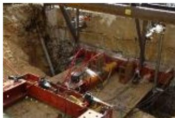
擁壁背面の状況
