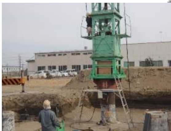
鉛直載荷試験
