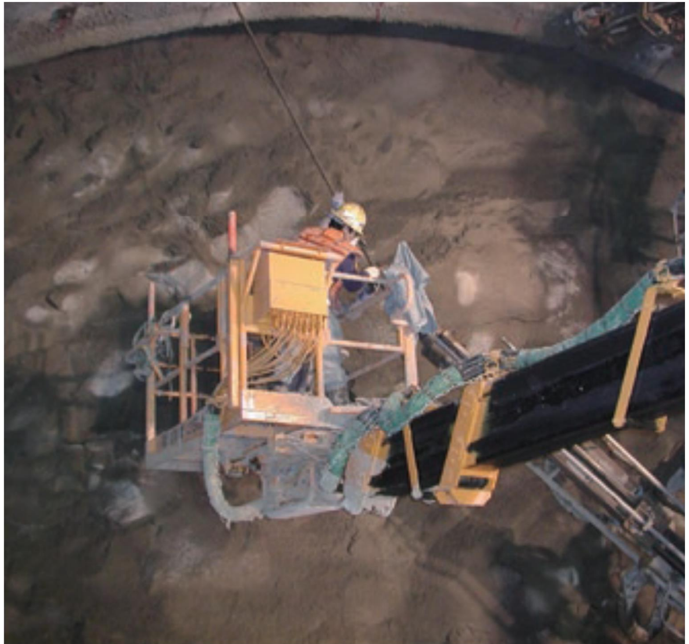
ロックボルト挿入作業状況
