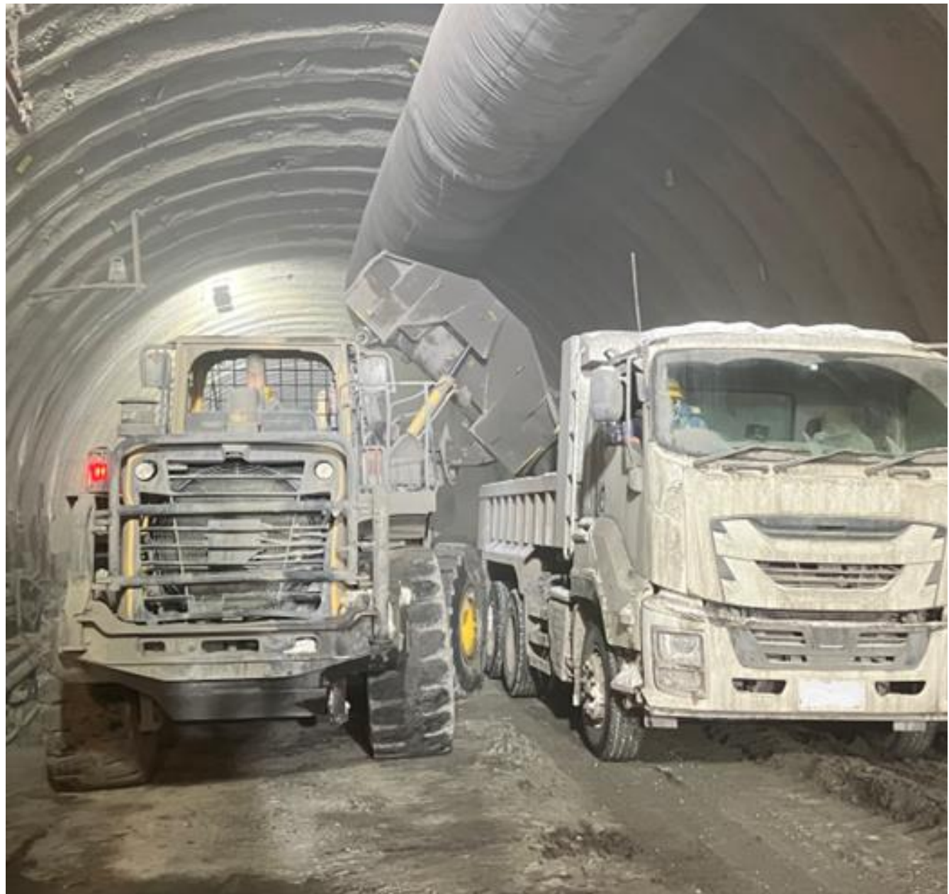
ずり積込作業状況
