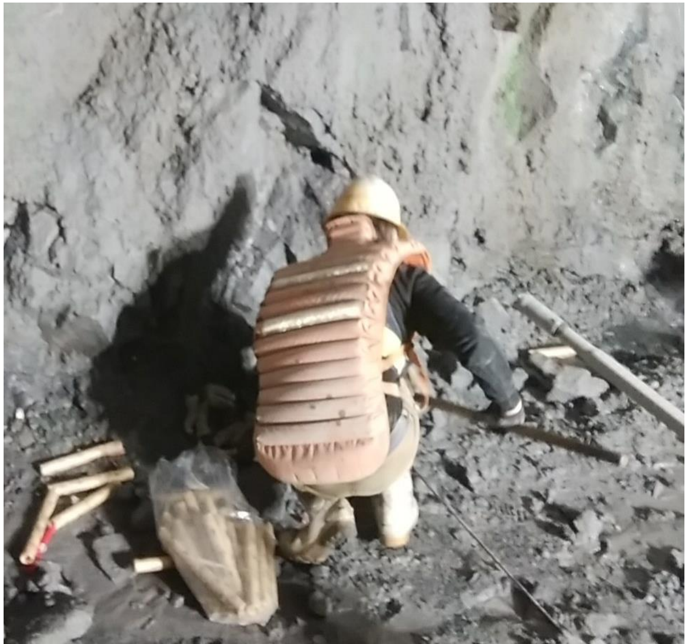
装薬孔清掃作業状況
