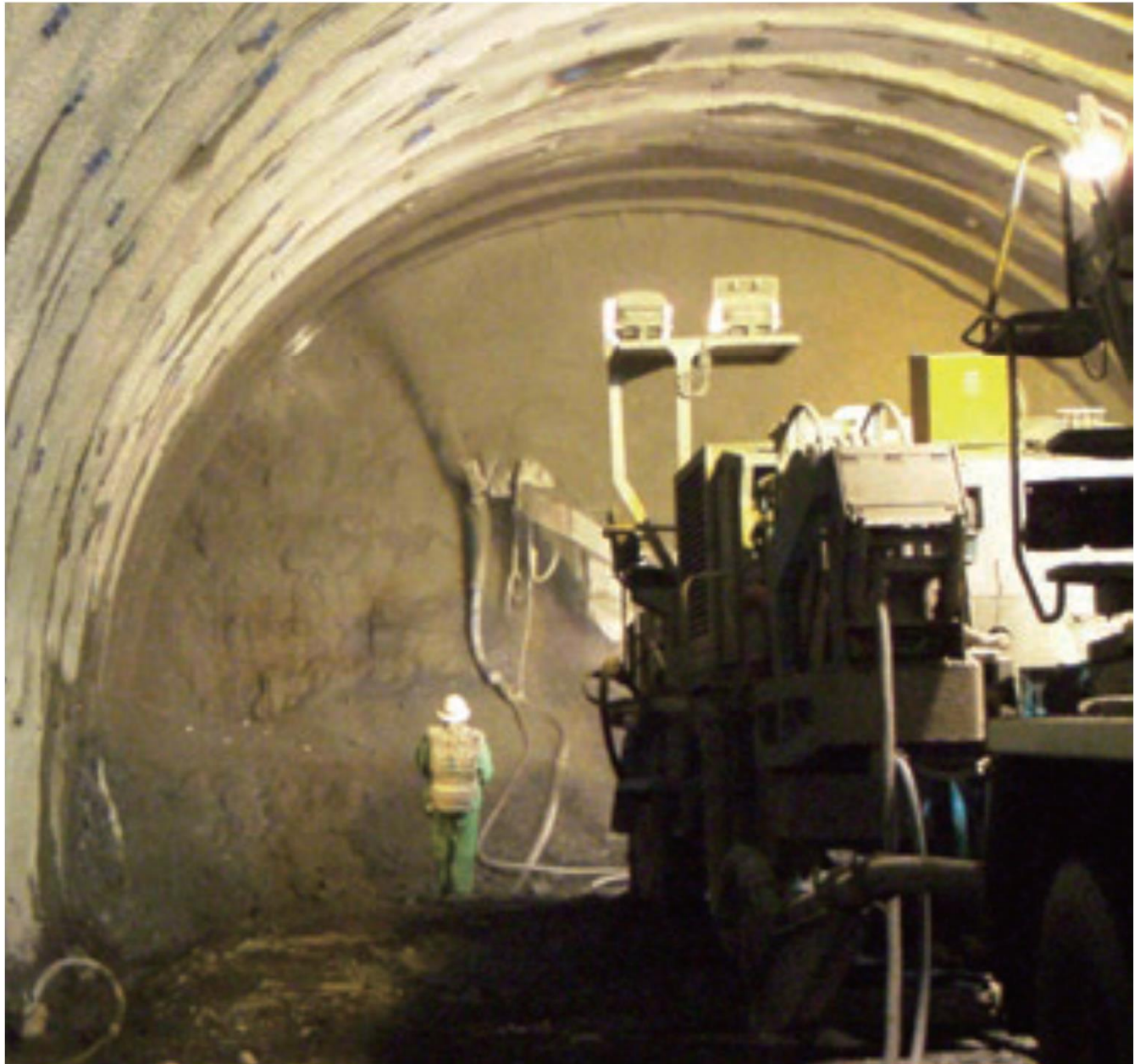
コンクリート吹付作業状況
