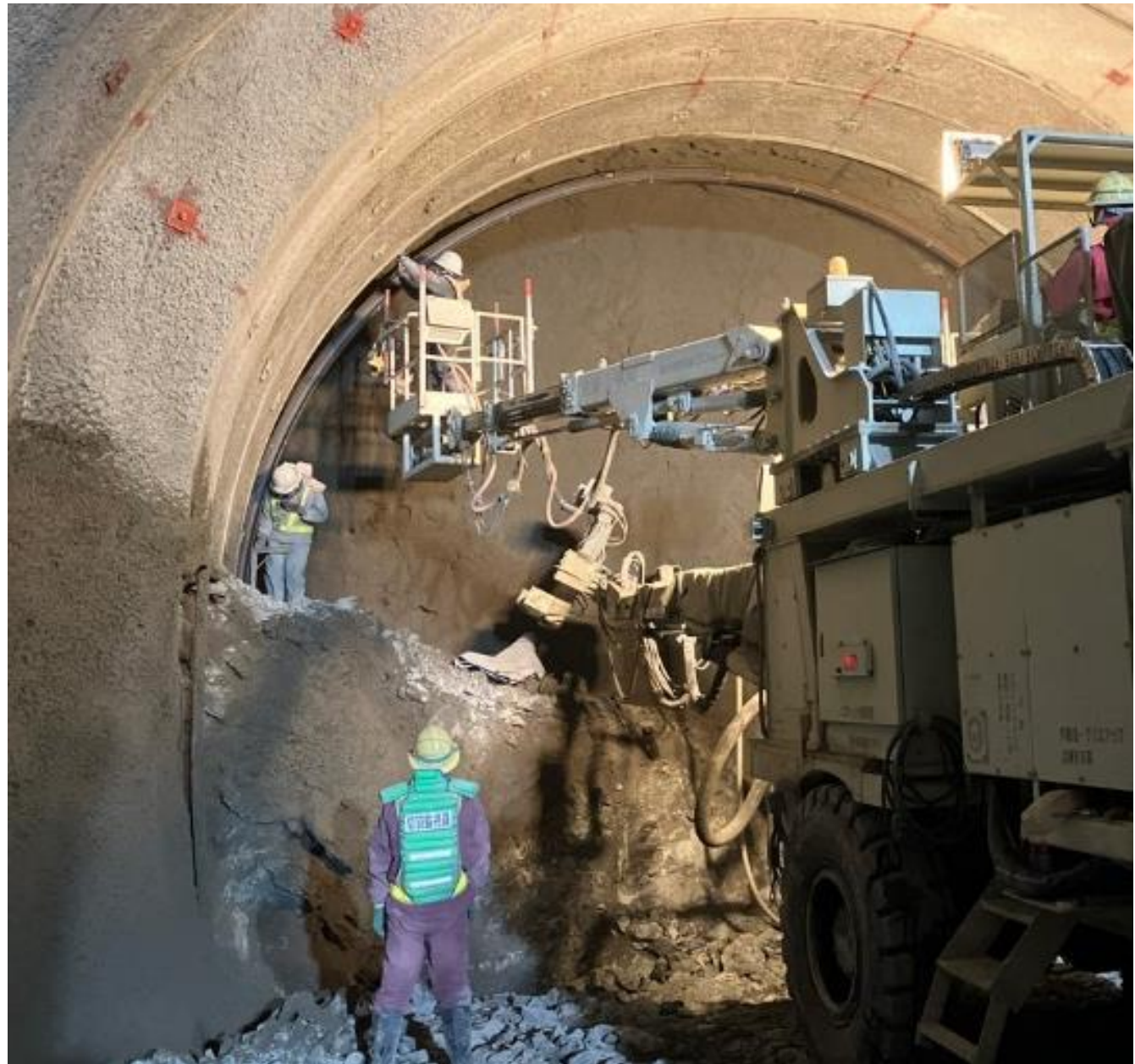
鋼アーチ支保工材ボルトナット仮締作業状況
