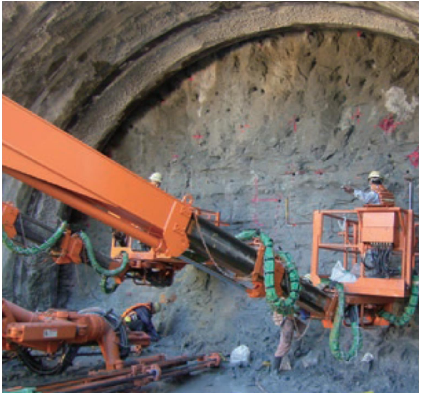
装薬作業状況
